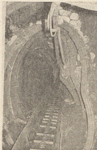
Odvozna proga v jami Hrastnik-Talni sklad, po hudih bočnih pritiskih (Foto Jože Kirič)
