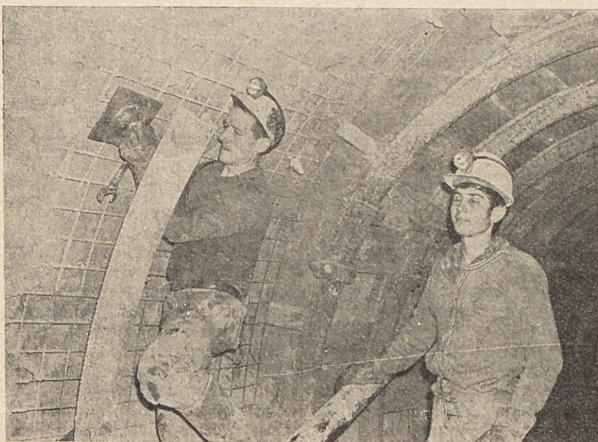
Permanizacija na VII. obzorju jame Hrastnik. Fotografija prikazuje mreže, sidra in brizgan beton v progi s talno glino (Foto inž. T. Bregant)
