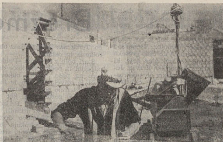
Gradnja nove klavnice v Kočevju poteka po sprejetem načrtu. Streho bo dobila že letos. Pozimi bodo na vrsti notranja dela. Prihodnje leto pa bodo v njej začeli montirati opremo. Proti koncu leta 1964 bo nova klavnica predvidoma že obratovala
