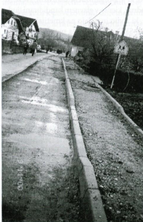
Gradnja pločnika proti šoli na Vidmu
