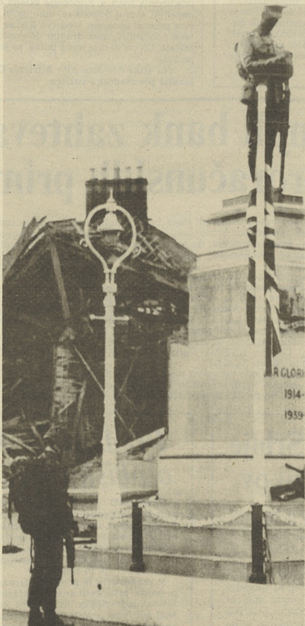
Pogled na prizorišče nedeljskega atentata: napol porušen socialni center in spomenik britanskim vojakom, ki so padli v 1. in 2. svetovni vojni (Telefoto AP)
