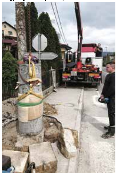
Zahtevna demontaža poškodovanega znamenja aprila 2019
