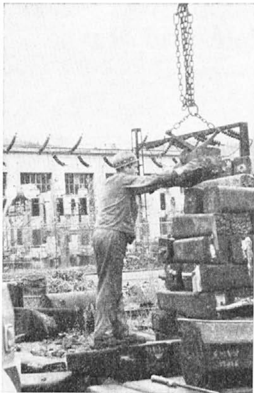
Pri zlaganju ingotov s pomočjo avtomobilskega žerjava se je ob udarcu na skladovnico ingot snel iz objema klešč in padel delavcu na nogo
