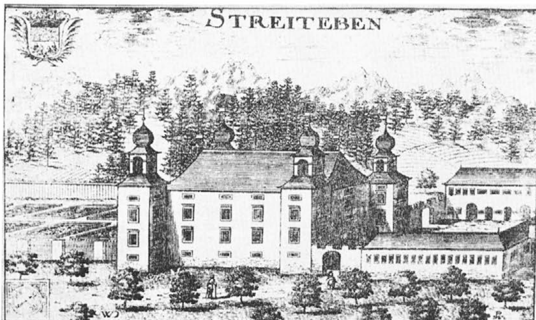
Grad Ravne je čisto nad trgom Guštanjem na prijaznem gričku in ima položna, dobra polja. Bil je last Matthiasa Süchtenskega, zdaj pa pripada Andreju Süchtenskemu (po Valvasorju)
