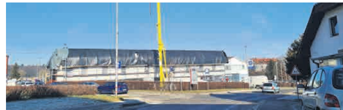
Po začetnem zapletu glede pokritja stroškov nepredvidenih del gradnje nadzidka zdravstvenega doma poteka s polno paro.
