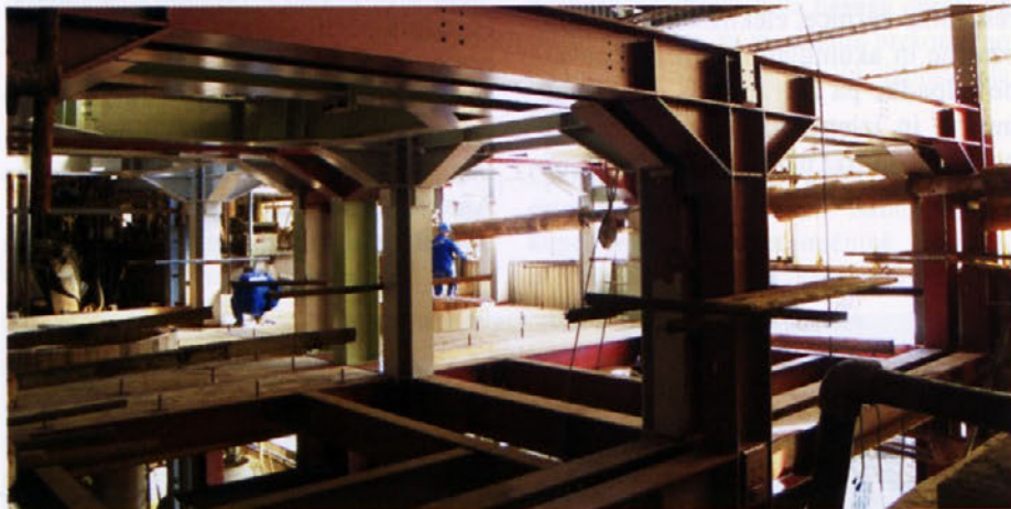
Takole je rasla nova konstrukcija nad 12 m ...
