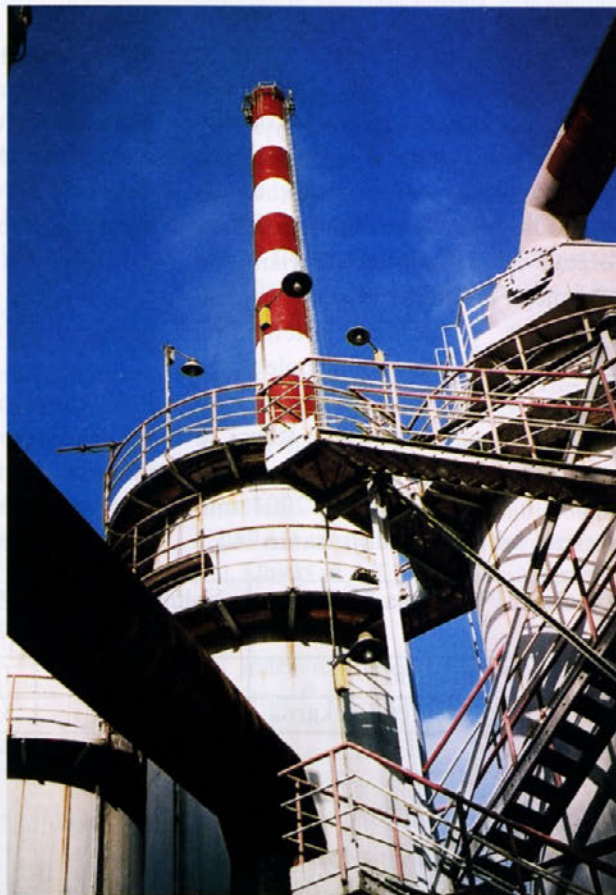
S-kislina z obnovljenim dimnikom
