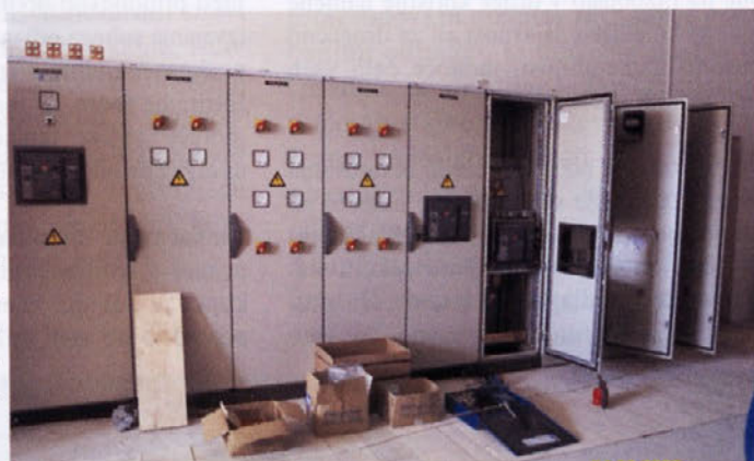
Trafo postaja 5 - 6 v fazi izgradnje
