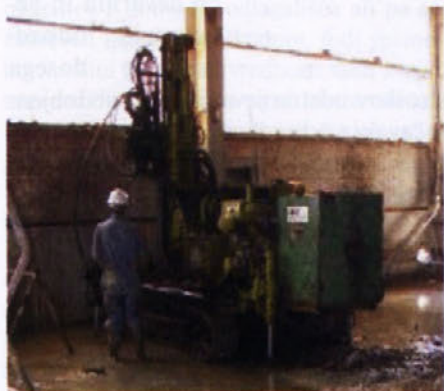
Začelo se je z vrtanjem pilotov
