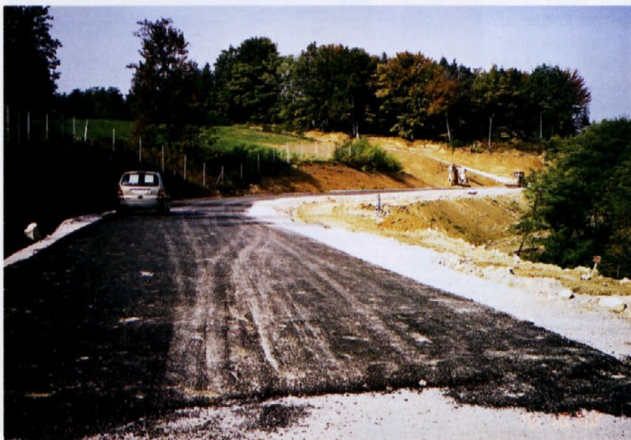
Nova servisna dovozna cesta na odlagališču Za Travnikom.
