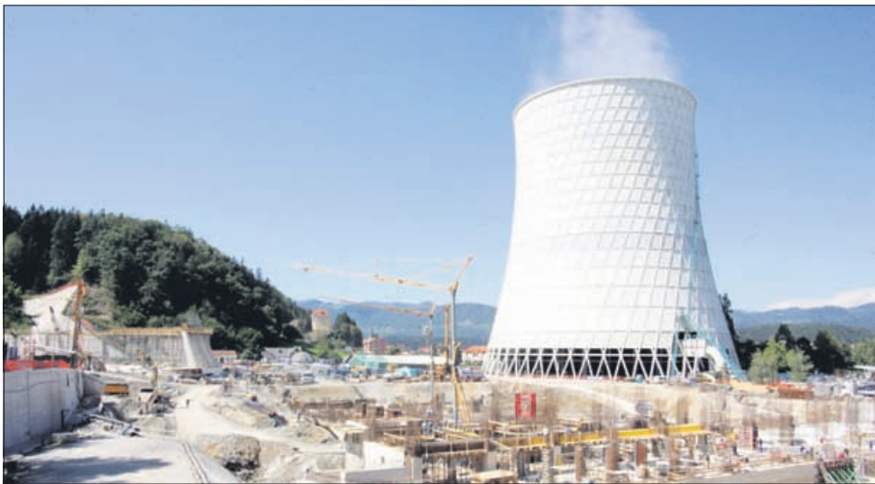
Gradnja bloka 6 se pospešeno izvaja. V »šestico« so vložili že 400 milijonov evrov.
