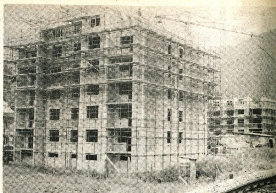
Izgradnja dveh blokov na Koroški Beli, kjer bo konec leta 72 novih stanovanj za delavce jeseniške železarne — Foto: S. Saje
