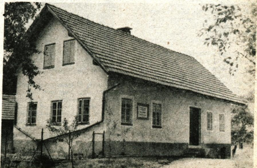
Levstikova rojstna hiša po obnovitvi.
