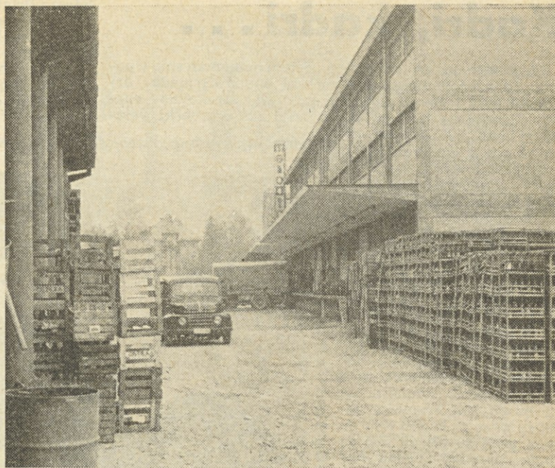
Prazna embalaža v glavnem skladišču je pripravljena za vrnitev
