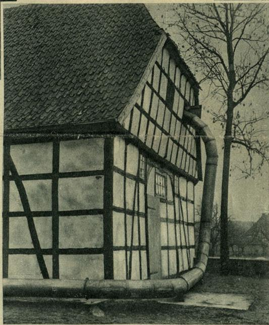
Bild 3. Die Rohrleitung der Gebläseanlage nach höheren gelegenen Böden
