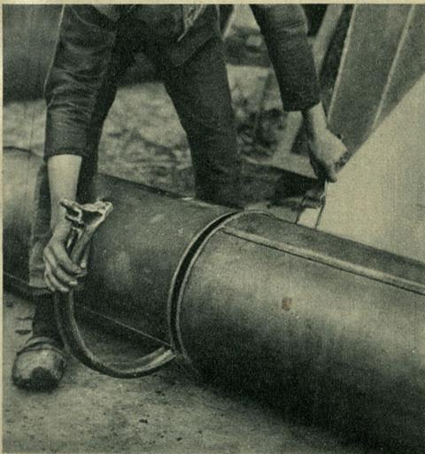
Bild 4. Verbindung zweier Rohrenden mittels einfacher Schelle
