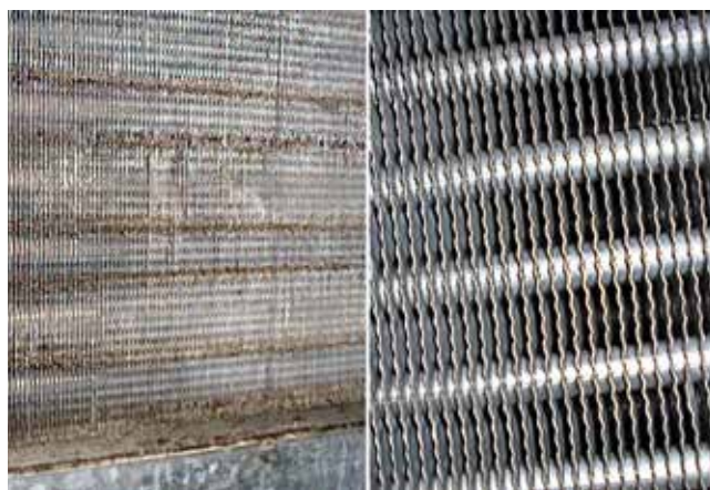
Slika 1 : Kondenzator pred čiščenjem in po njem
