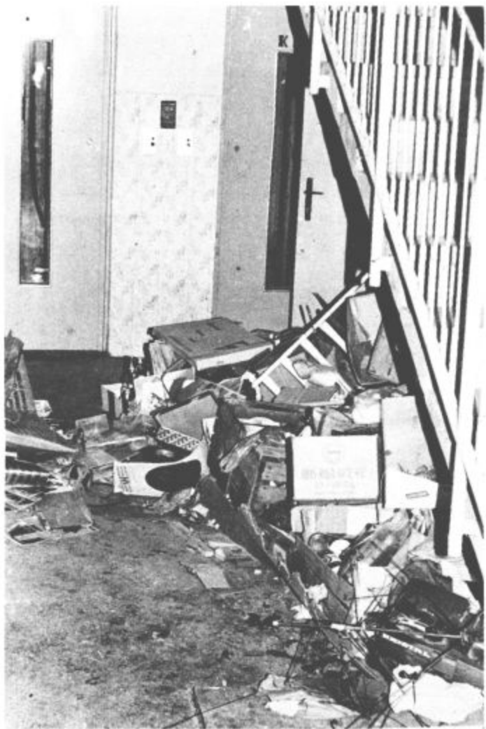
Gornji posnetek smo naredili v kletnih prostorih (pred vhodom v dvigalo) na Foitovi 8. V času, ko si vsepovsod prizadevamo za boljše gospodarjenje in varčevanje na vseh ravneh, takšen odnos do objektov, v katerih živimo, ni niti najmanj v skladu z našimi prizadevanji. Posnetka: D. B.
