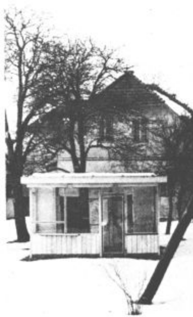
ČRPALKA — Tole bi morala biti bencinska črpalka v Gornjem gradu, pa sedaj zagotovo ne bo. Usoda tegale „objekta“ je sedaj negotova.
