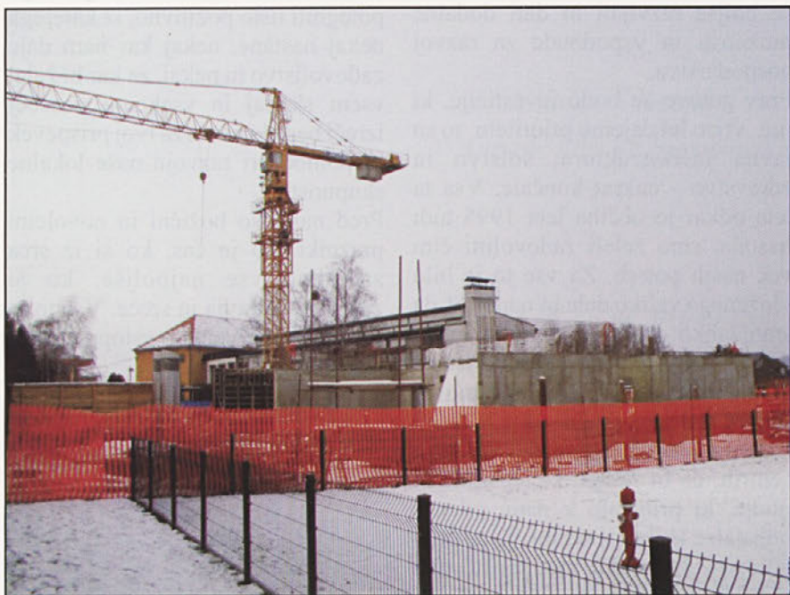
Gradbišče pri OŠ Gorišnica
