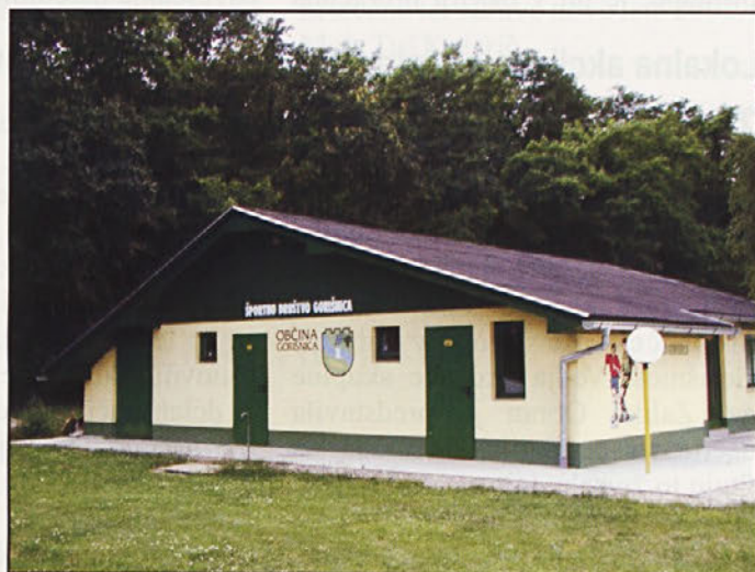
Ob športnem igrišču stoji tudi lepo urejen spremljevalni objekt
