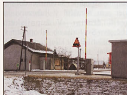
Nov, avtomatiziran, železniški prehod v Zamušanih.
