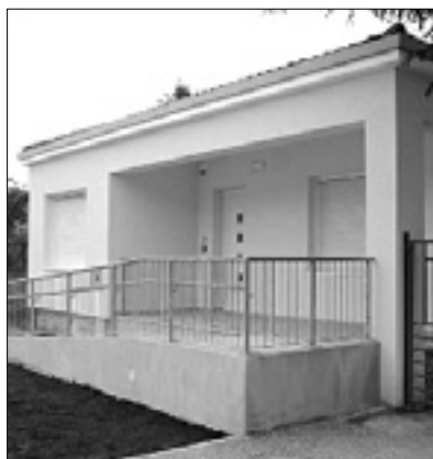
Obnovljeni mejni objekt na Rafutu
