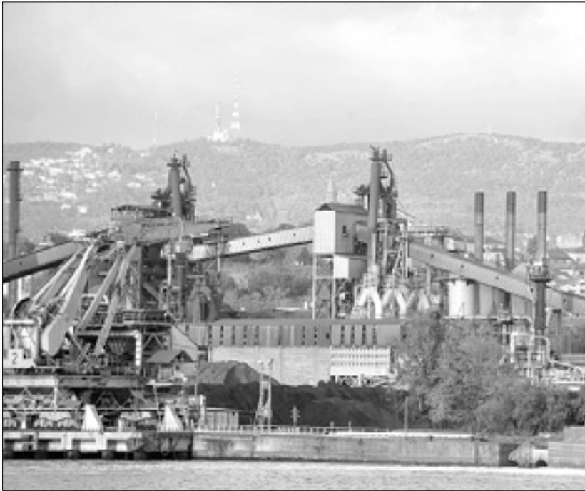
A.G. Pogled na škedenjsko železarno
