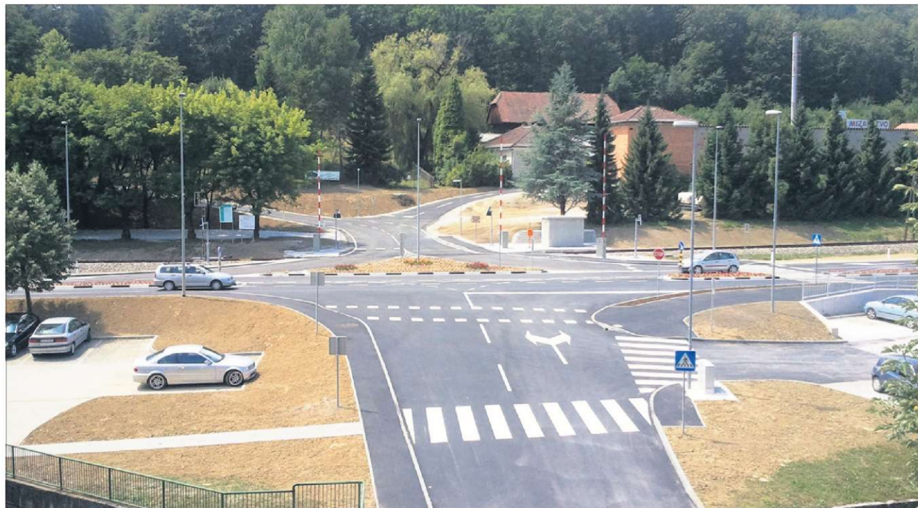
Železniški prehod pri nekdanjem Mizarstvu je bil veliko let ena črnih točk Rogaške Slatine. Občina je križišče v sodelovanju s Slovenskimi železnicami celovito uredila leta 2011. Tudi ostala križanja cest z železnico v mestu so po besedah pripravljavcev študije zgledno urejena.
