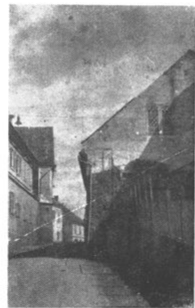
Pred kratkim so delavci KG Lenart začeli z rušenjem zgradbe, ki stoji na desni strani severne magistrale ob vhodu v samo središče Lenarta. Na naši sliki vidimo to zgradbo na desni strani, ki zajema več kot polovico slike. (Foto: T. Stefanec)
