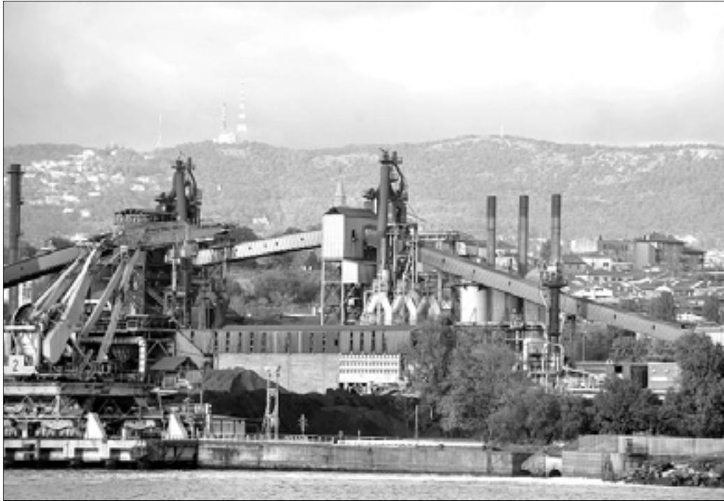
Pogled na škedenjsko železarno
