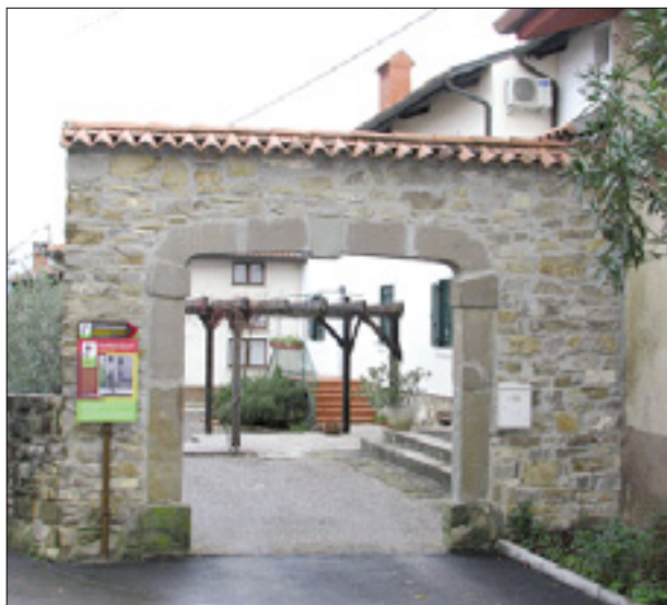
Vhod v pesnikovo rojstno hišo (levo); notranjost poslopja (zgoraj)
