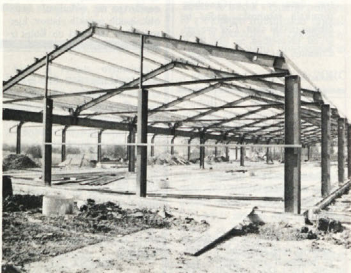
Skladiščno-proizvodni prostori „KOMET“ v izgradnji
