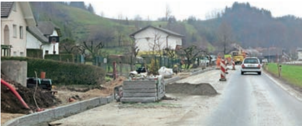
V Srednji vas gradijo pločnik, urejajo meteorno kanalizacijo in prenavljajo telekomunikacijsko infrastrukturo. / Foto: JASNA PALADIN
