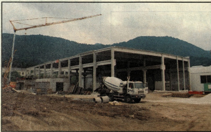
Izgradnja nove hale
