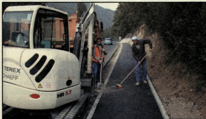
Izgradnja tretje faze pločnika v Letušu
