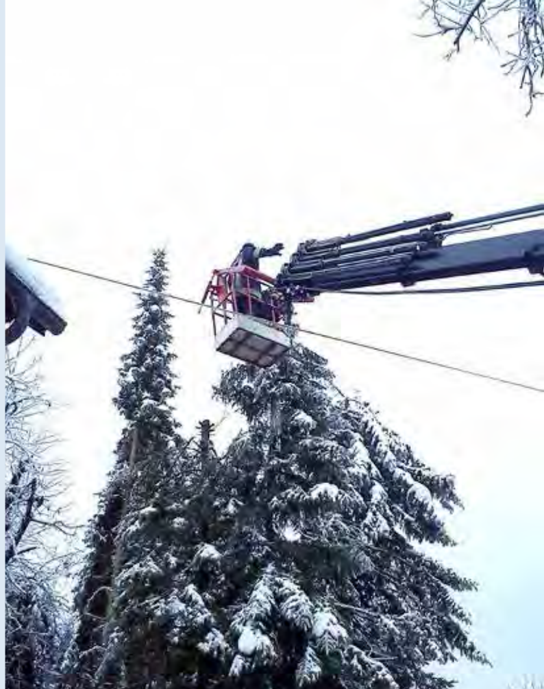
Na Jelovškvi v Mengšu je nagibanje smrek ogrožalo stanovanjsko hišo in električno napeljavo. Smreke smo požagali s pomočjo avtodvigala.
