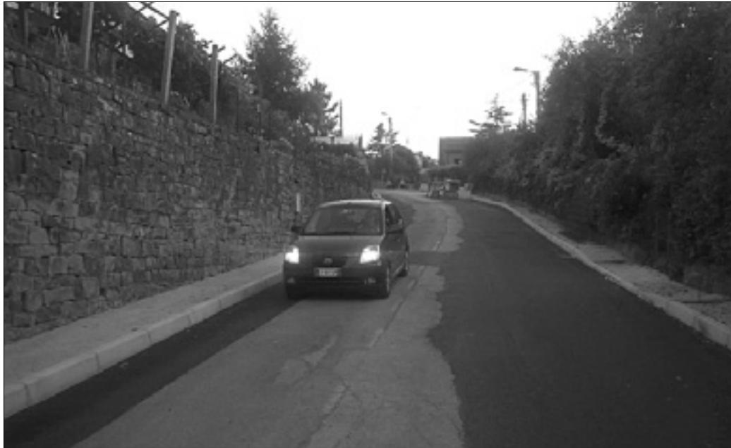
Nova asfaltirana cesta
