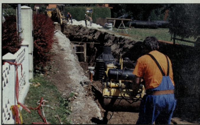
Pri izgradnji kanala skozi vas Šentrupert
