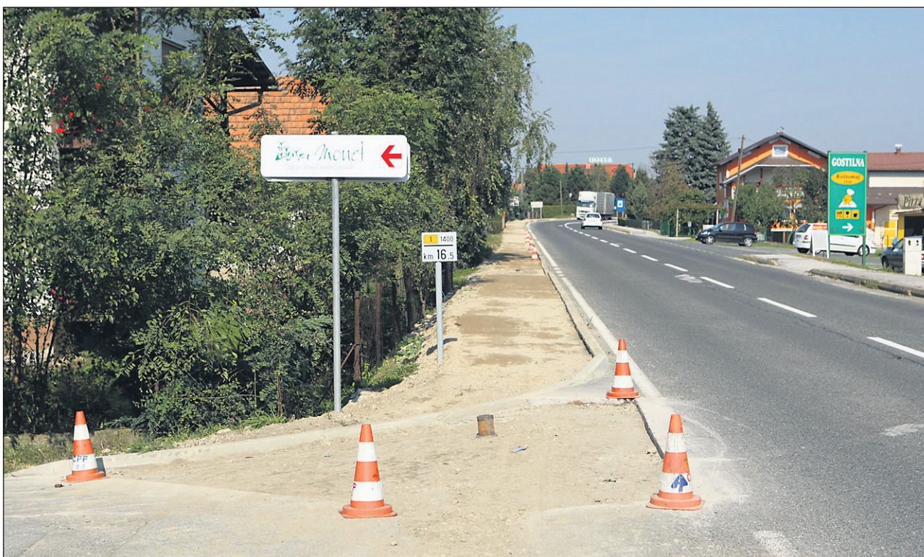
V sklopu izgradnje kanalizacije so v občini Hajdina v zemljo položili tudi drugo infrastrukturo, sredstva za to so zagotovili v občinskem proračunu.
