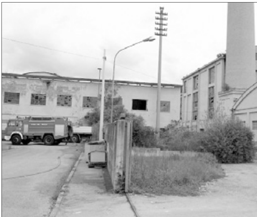
Gasilci na delu v nekdanji tovarni
