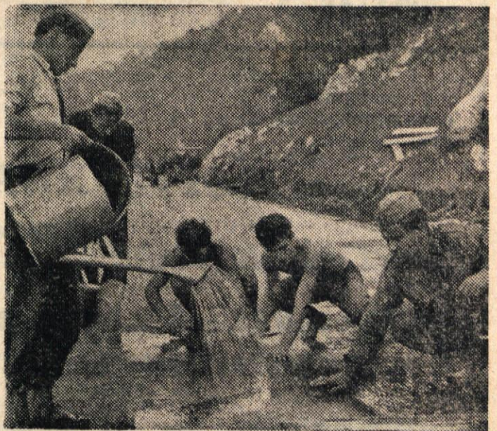
Pred tedni so začeli novo cesto v Srbiji že betonirati
