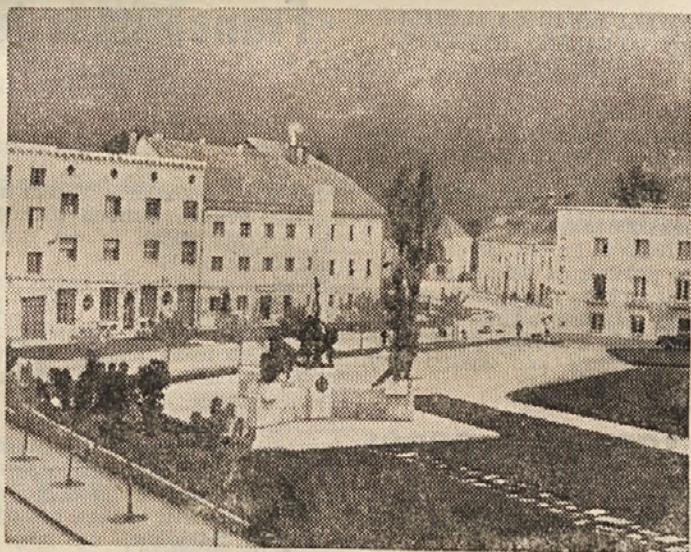
Pogled na središče obnovljenega Kočevja
