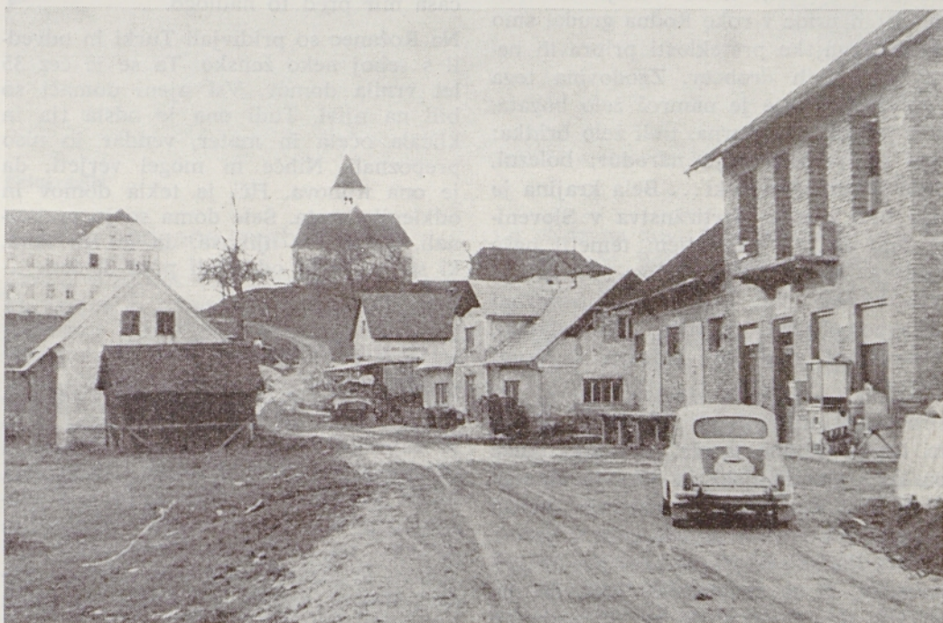
Pogled na porušeno in delno že obnovljeno Zibiko
