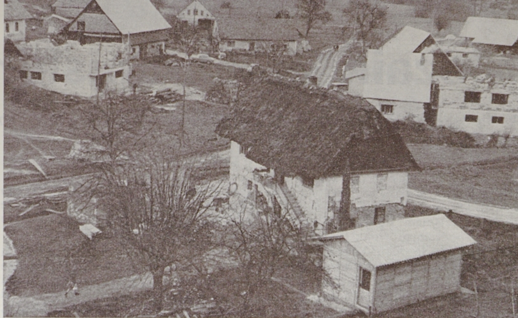
Porušeni Kristan vrh obnavljajo v celoti
