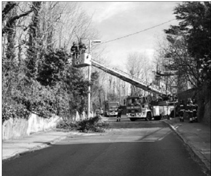
Nad Ul. Commerciale je nevarno viselo drevo
