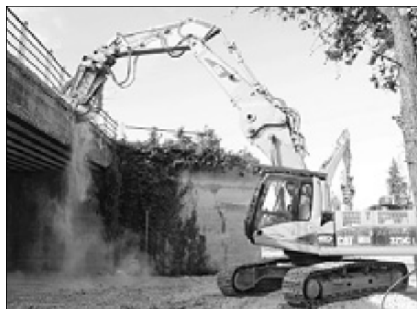
Včerajšnje rušenje nadvoza nad deželno cesto
