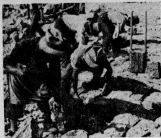
Tlakovanje dna s podpeškim lomljencem. Delavci v glavnem zlagajo lomljeni kamen. Le sem in tja ga po potrebi tudi nekoliko oklešejo.
