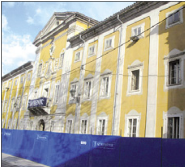
Freske, ki so jih odkrili na stropu, so dobro ohranjene (zgoraj), dvorec Lanthieri med obnovo (levo)
