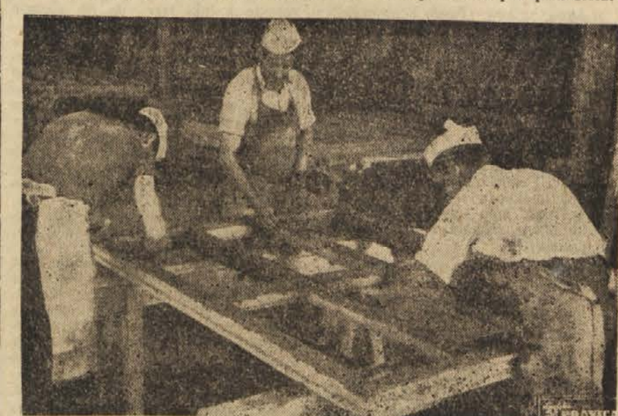
V »Litostroju« gradijo po montažnem sistemu. Poleg gradilišča so zato postavili delavnico, v kateri izdelujejo delavci in delavke betonske dele zgradbe, ki jih nato na stavbi montirajo. Izdelujejo tudi betonske okvirje za okna ter so s tem načinom izdelovanja okenskih okvirjev prihranili mnogo časa in denarja, ker danes še posebno primanjkuje suhega lesa. Na sliki: Delavci pri izdelovanju betonskega okna.
