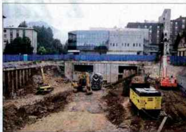
Gradbena jama za garažno hišo.
