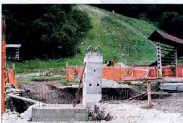
Betonski temelji so že pripravljeni.
