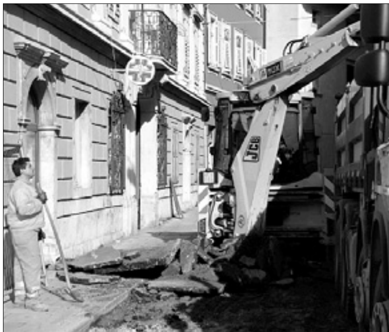
Gradbišče na začetku ulice Monache
