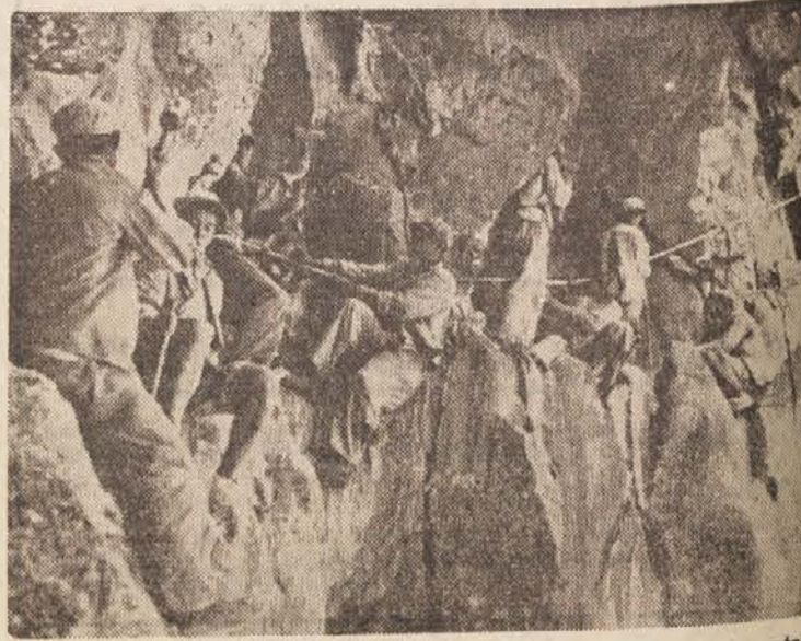
V vrtočlavi višini 4000 m grade Kitajci v Tibetu. »Strehi sveta« velikanstvo cestno omrežje, dolgo v celoti 5082 km. S temi cestami so povezali »prepovedano mesto« Lhaso s Kitajsko. Kot kaže naša slika, je delo silno nevarno in opravljajo ga z dokaj primitivnimi sredstvi
