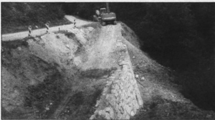
Delo na plazu v Pavlovi vasi
