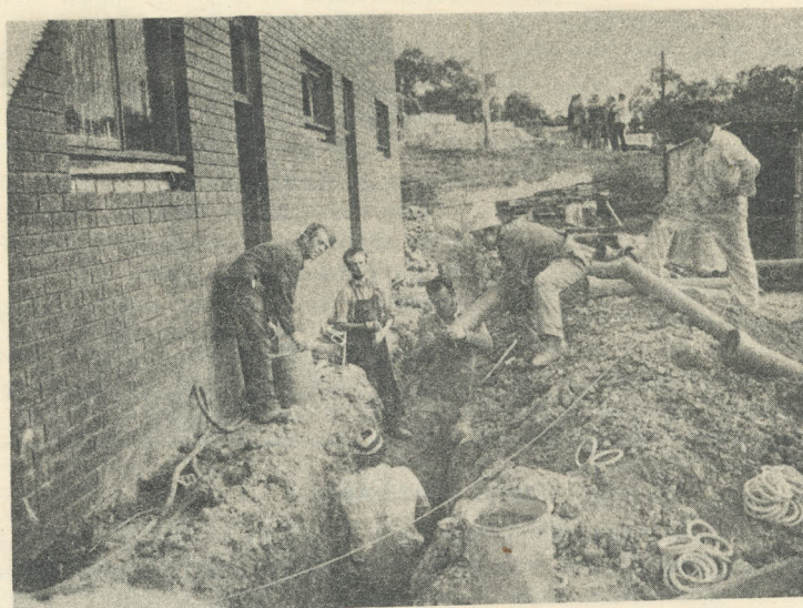
Polaganje sanitetnih naprav
