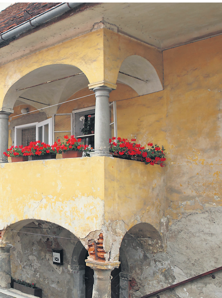
Obnova Dravske 23 je v planu. Trenutno se zanjo pripravljajo kulturno-varstvene smernice.
