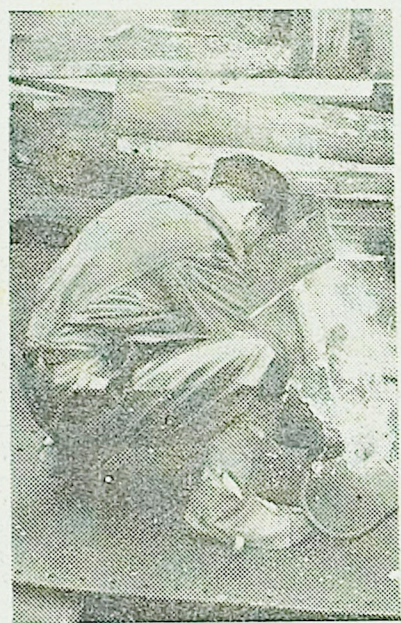
Delavce Piranske ladjedelnice vari pločevino
