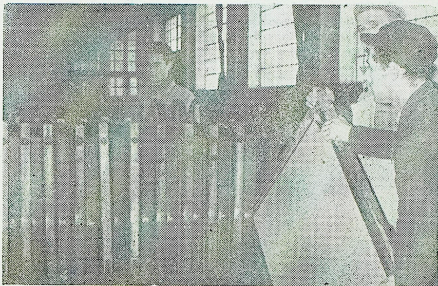
Stiskalnica Tovarne mila v Piranu. Slika kaže vlivanje mila v plošče
