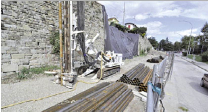
Gradbišče v Škedenju; gradbeni sektor je pod udarom
