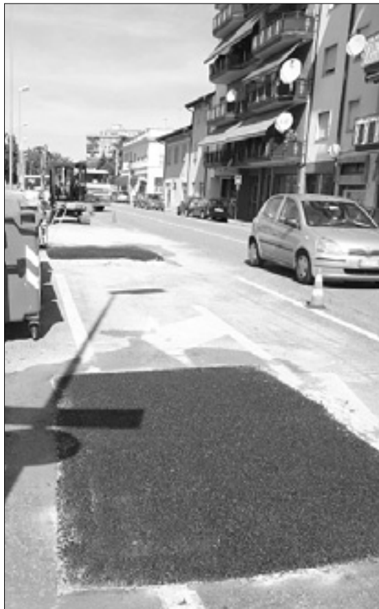
Pokrpno cestišče v Ulici Verdi
