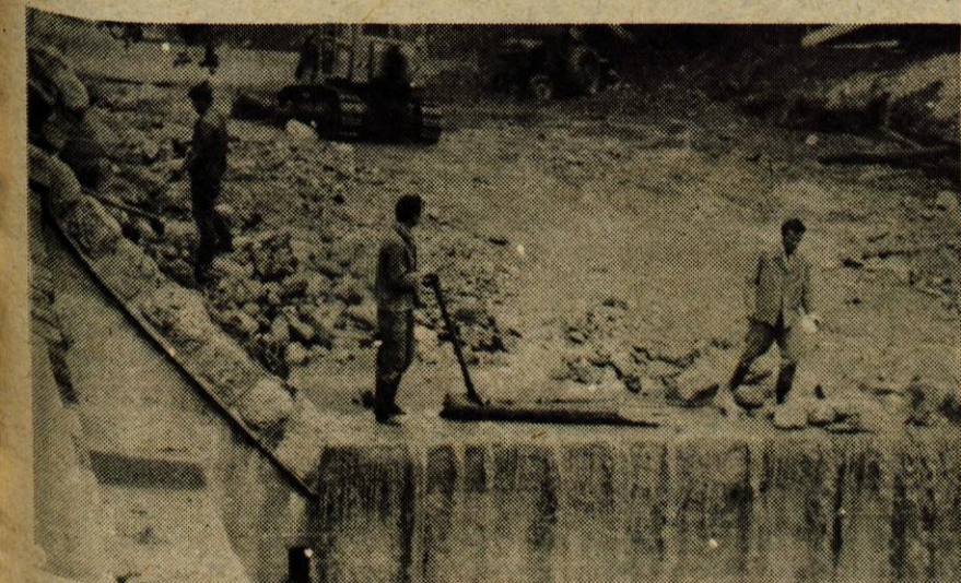
Delavci podjetja Hudournik te dni urejajo dve pregradi na hudourniku Jese- nica ter obrežne zidove pri domu starostnikov na Plavžu na Jesenicah. Regulacija hudournika je bila nujna, da ne bi narasla voda začela najediti bregove tik ob novozgrajenem domu dr.Franca Bergla. Dela naj bi bila opravljena še ta mesec. Sredstva za regulacijo je prispevala Gorenjska vodna skupnost, ki ima v letošnjem programu predvidenih 2,9 milijona din za redno vzdrževanje obrežij in pregrad na hudournikih v jeseniški občini. — Foto: B. Blenkus
