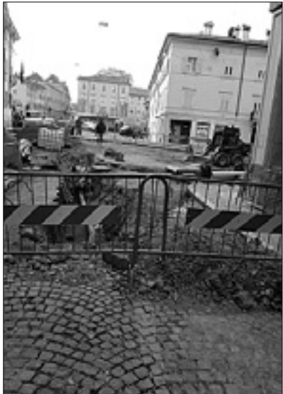
Gradbišče ob vhodu v Ulico Mazzini
