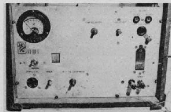
Radljska sprejemno-oddajna postaja Hajka III, izdelana v radiodelavnicah v Starih žagah, 1944
