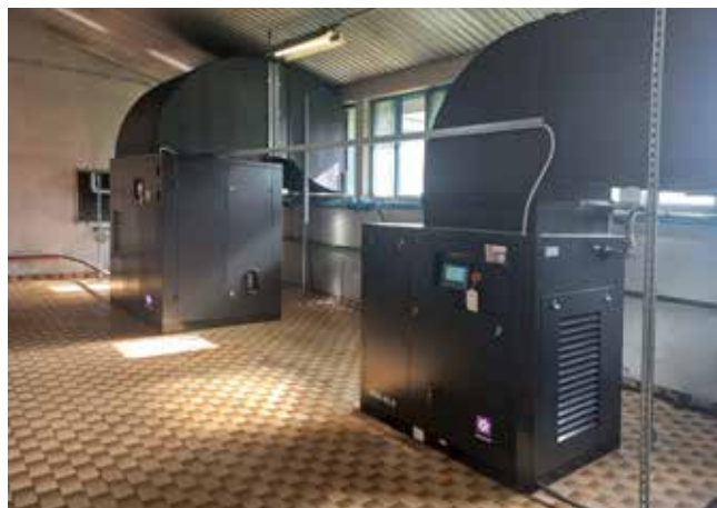
Slika 1 : Dva kompresorja, ki lahko delujeta po sistemu zanesljivosti »backup«.
