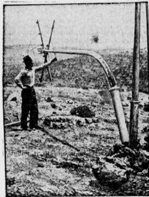
Arabci v boju proti Angležem v Palestini ne prizanašajo nobenim javnim napravam. Na sliki: poškodovana telefonska proga.
