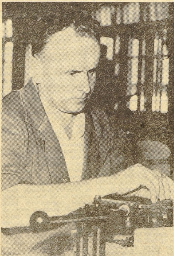
Tudi slepi in drugi invalidi v sodobni proizvodnji lahko prispevajo svoj delež. Na sliki: slepi Anton Gorenjc nastavlja stranice na jedra relejev
